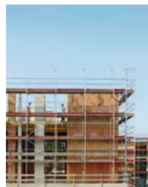
Regola 4 Montare il ponteggio per facciate.
