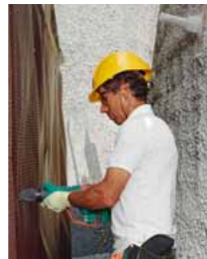
Regola 8 Mettere in sicurezza gli scavi.
