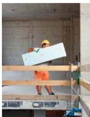
Regola 2 Mettere in sicurezza le aperture nel pavimento.
